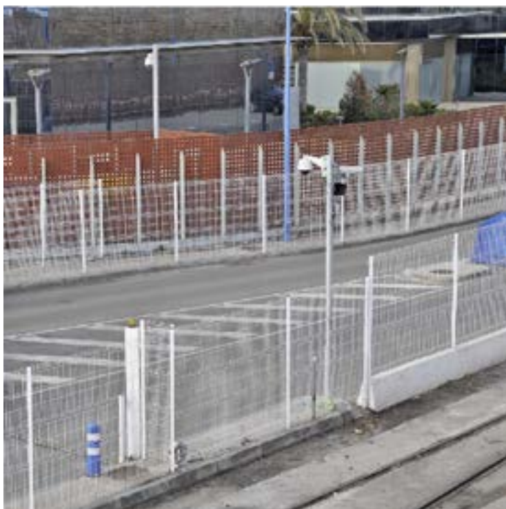
Vallado inteligente de Magal en el Puerto de Tarragona. Fuente: La Directa 217 .
